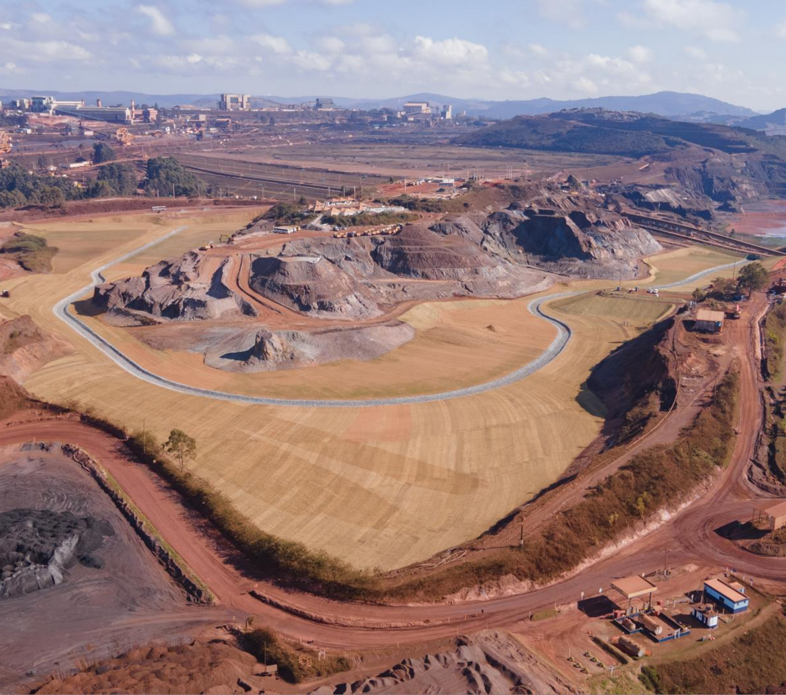
Obras de descaracterização da barragem de Fernandinho concluídas em julho de 2021
